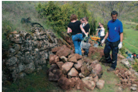
Recuperació de camins a la Vall Fosca en el marc d'un camp de treball internacional. Arcadi Castelló
